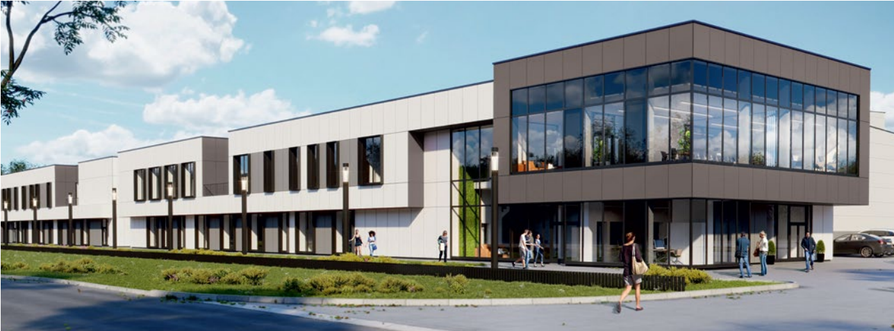
Nowo wybudowane Centrum Badawczo-Rozwojowe Lubawa S.A. The newly built Lubawa S.A. Research & Development Center
